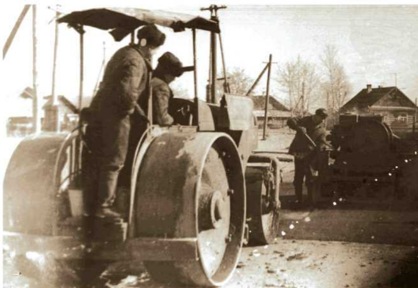
Асфальтирование улицы Кирпичной. 1972 год.
