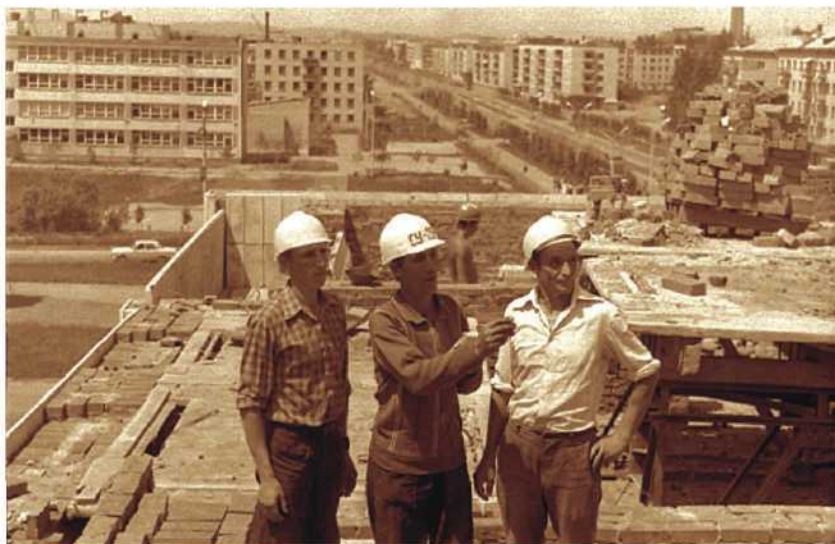
Строительство первого 9-этажного дома. Строительство ведет СУ-256. 1983 год.
