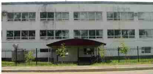
ОАО «Электротехническая компания «Биробиджанский завод силовых трансформаторов». 2011 год.
