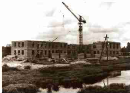
Строительство Дворца культуры. 1959 год.
