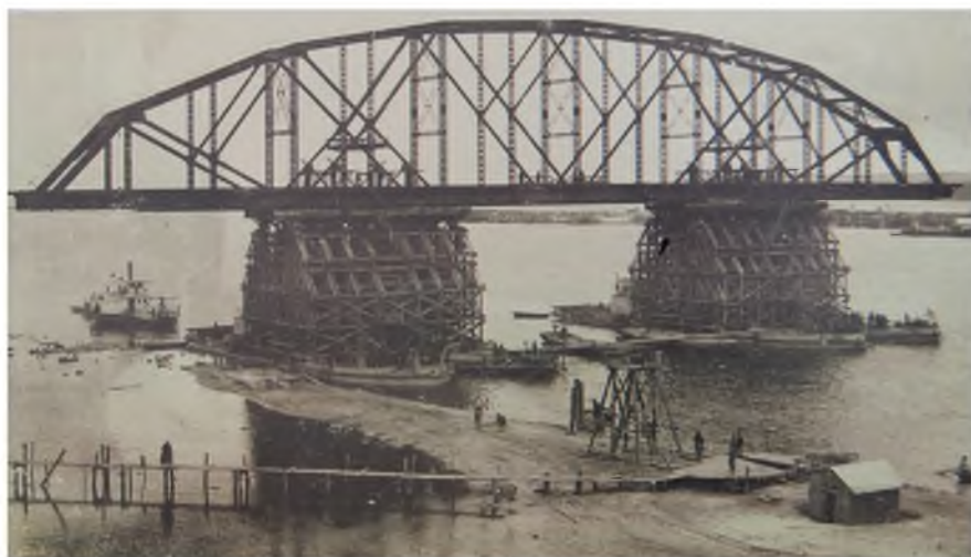
Строительство железножоржного моста через Амур
