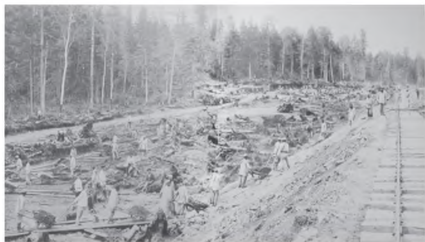
Строительство железной дороги
