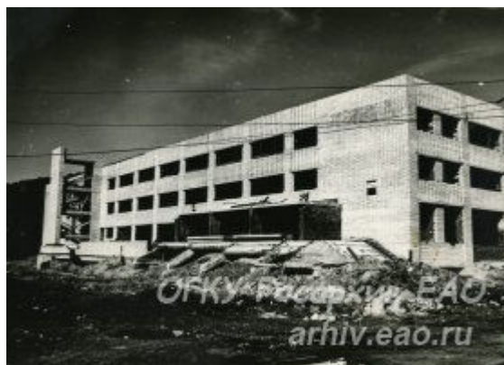
Пос. Кульдур. Строительство клуба на 800 мест. Б/д. ГАЕАО. Ф. Р-505. Оп. 1. Д. 830. Л. 14об.
