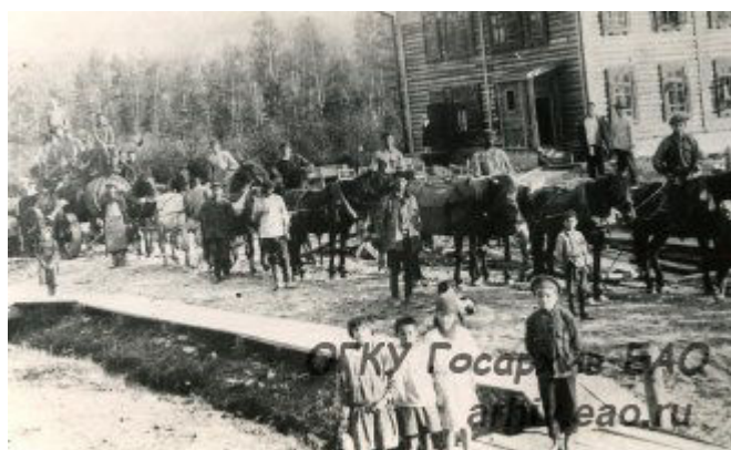
Подвозка оборудования для первой электростанции. 1932 г. ГАЕАО. Ф. Р-505. Оп. 1. Д. 830. Л. 5об.
