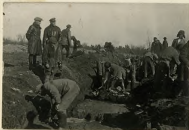
Закладка обозного завода.
