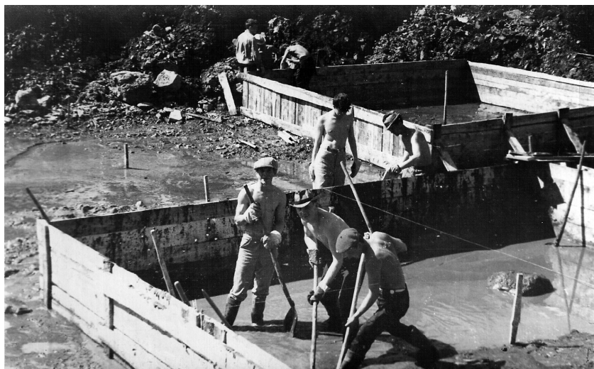
Строительство фундамента первой поворотной опоры канатной дороги рудник «Фестивальный» - «Солнечный обогатительный комбинат», студенческий строительный отряд «Механик-69», пгт Солнечный, Хабаровского края, июль 1969 года, автор во втором ряду слева
