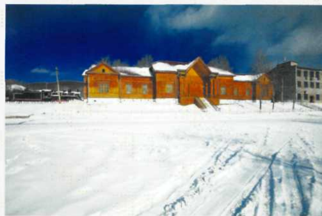
Здание станции поселка Высокогорный
