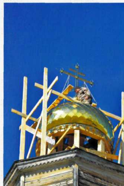
Работы по установлению нового купола колокольни Атамайской Николаевской церкви
