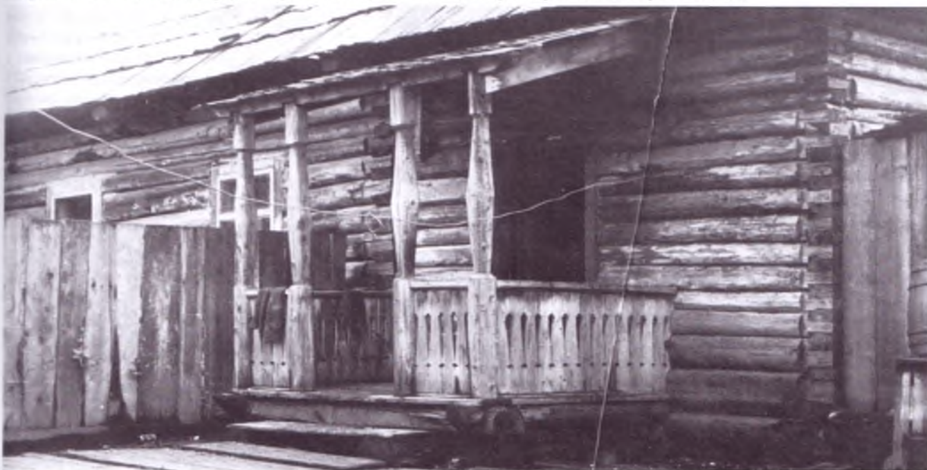
На фото: крыльцо дома семьи Онищенко по ул.Вокзальной, 32 в Бире. Дом сохранился до сих пор.
