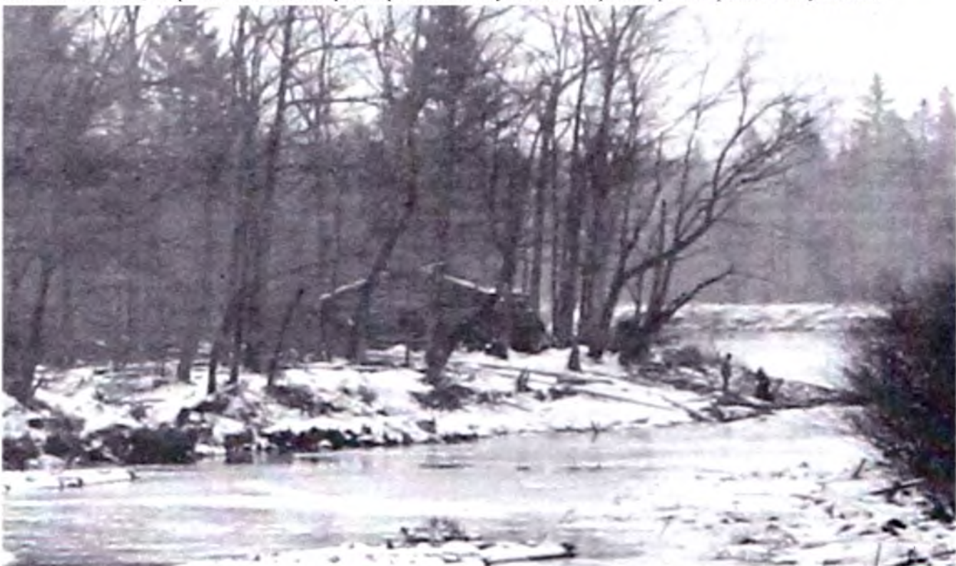
Фрагмент фото из альбома «Строительство 4 участка Восточной части Амурской ж.д., 1912 г.» (РФ ДВГНБ) с надписью: «Лесопилка на ст.Бира...». В глубине снимка на берегу Биры видна, скорее всего, сторожка паромщика.
