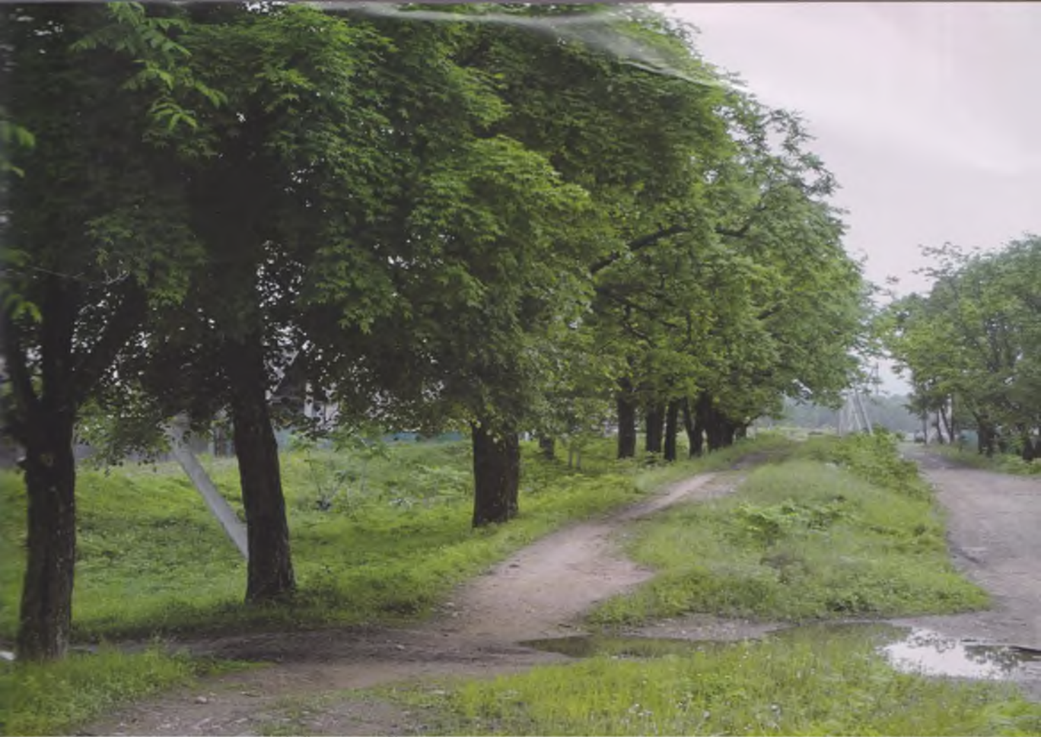
Бирские дамбы (насыпи) с уложенным под ними трубопроводом, идущим от водокачки до водонапорной будки. Трубы чугунные, на фланцевых соединениях. Водопровод построен в 1912 году и действует по настоящее время.
