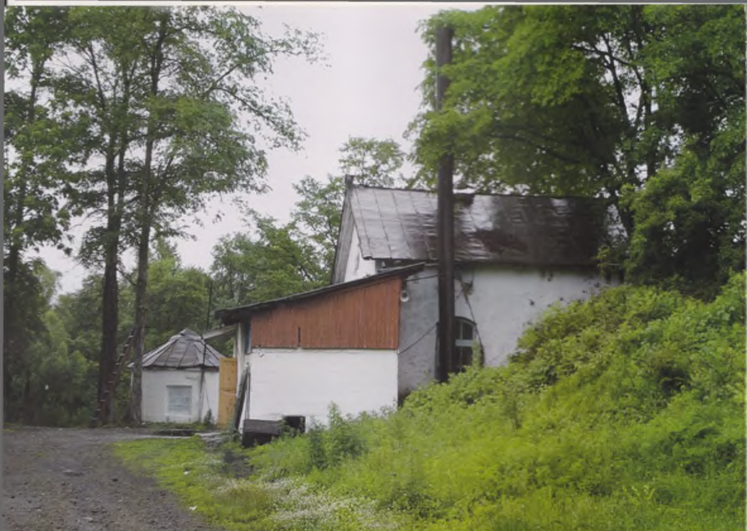
Здание Бирской водоканчки (на берегу реки Биры). Построено в 1912 году (слева от здания — современная пристройка).
