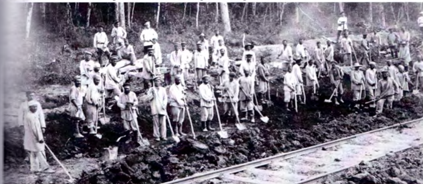
Фото из ГАХК: каторжане на постройке Восточной части Амурской железной дороги.
