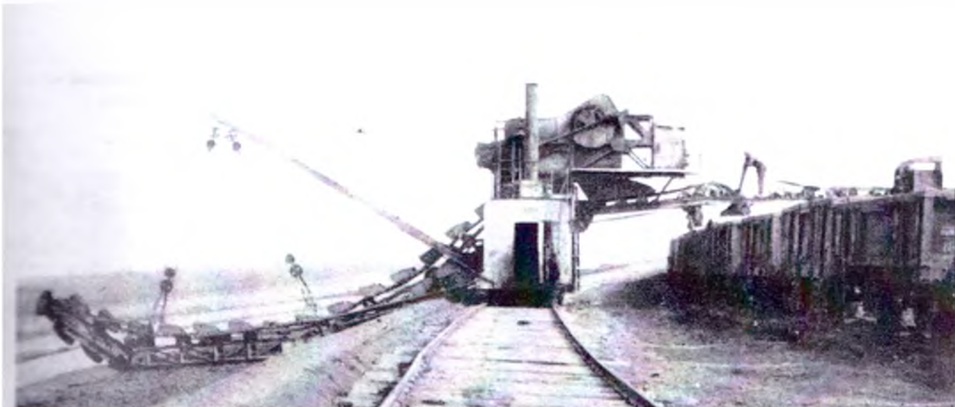
На фото: работа многоковшового экскаватора-«путиловца» близ Хабаровска.
