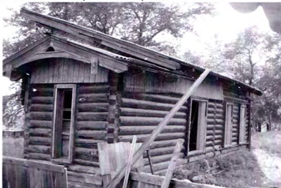
На фото: остатки здания школьных мастерских по ул.Школьной.
