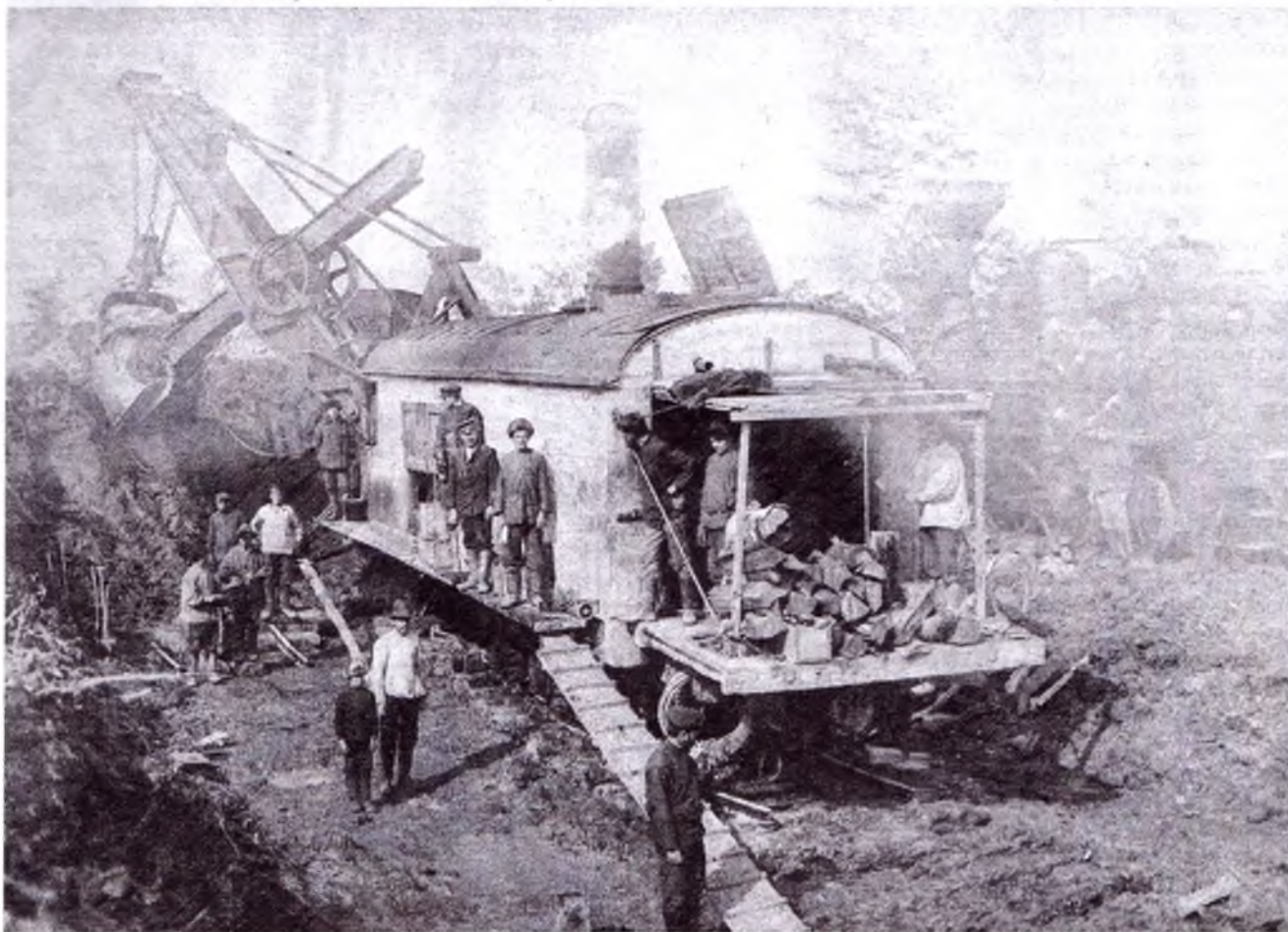
На фото: паровой экскаватор на строительстве Восточного участка Амурской железной дороги. (ГАХК)
