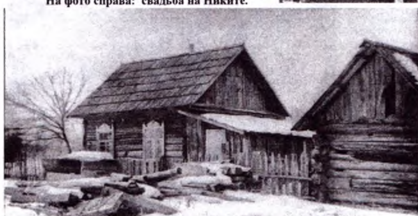
На фото: частные дома и местные жители посёлка Никита.
