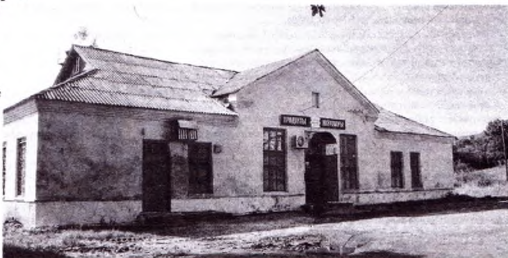
На фото: здание бывшей бирской пекарни (было построено в 1941 году).
