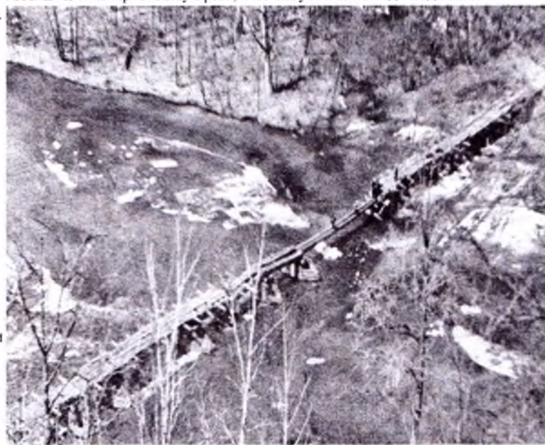
На фото: мост узкоколейной железной дороги Бирлага через речку Никиту.
