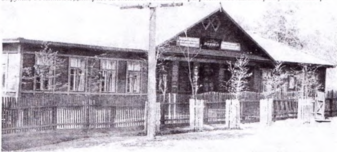
На фото: контора линейного железнодорожного предприятия ШЧ-2 станции Бира.
