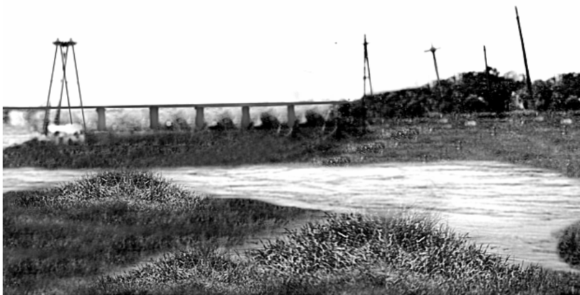
Мост через Бирю
