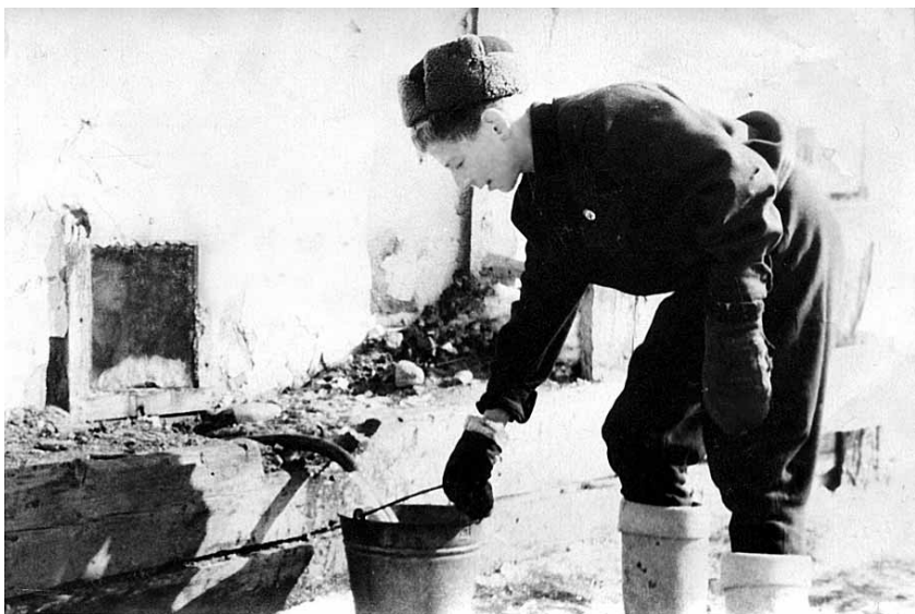
Водопроводная колонка на ул. Калинина
