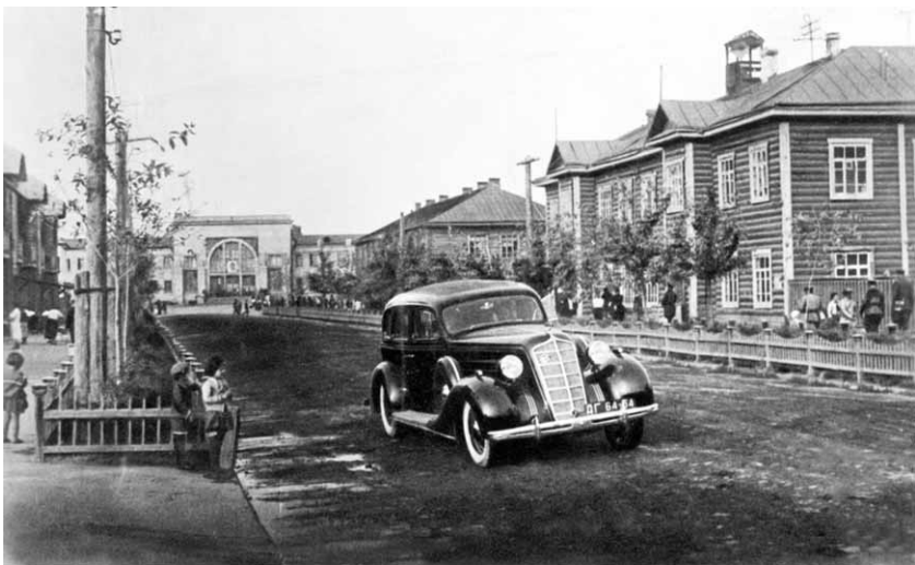
Ул. Октябрьская. На крыше здания (справа) установлен громкоговоритель
